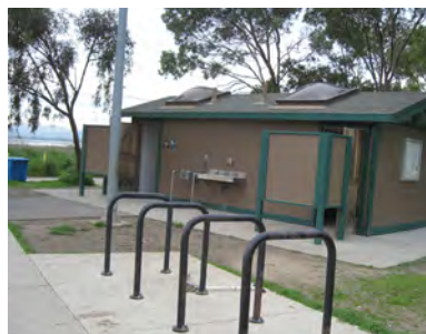
Enhanced Existing Restrooms Hacer mejoras en los baños
