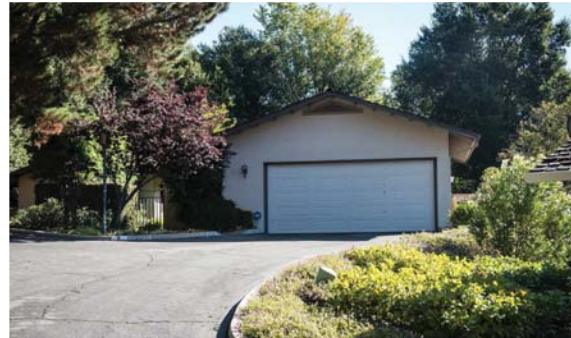
EXISTING GARAGE DOOR
