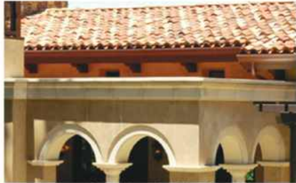
ROOF DECK EDGE CORNICE
