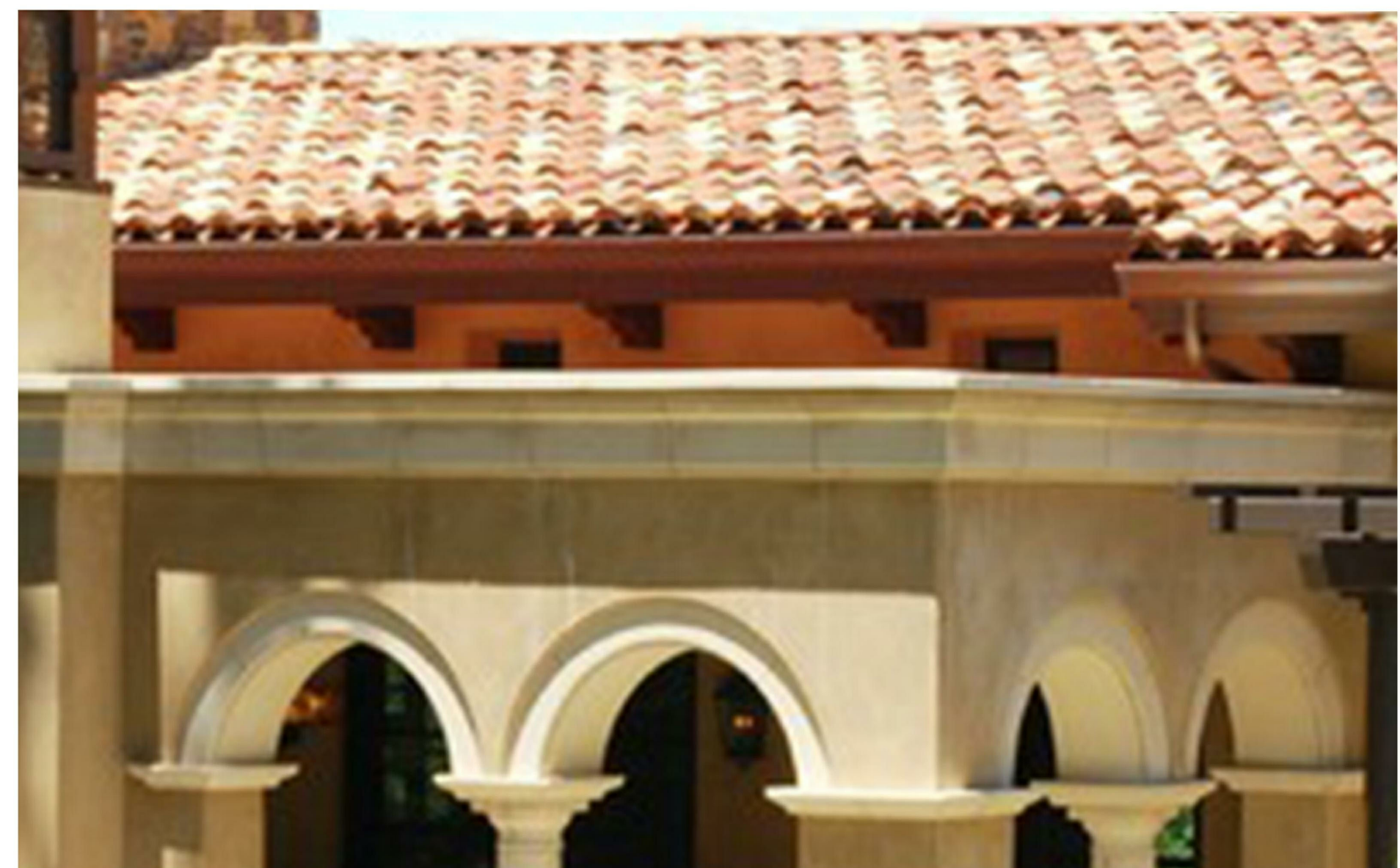
ROOF DECK EDGE CORNICE
