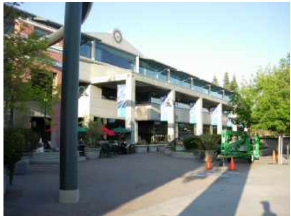
Existing Menlo Center (Menlo Park,, California)
